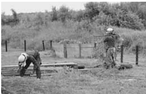
武ダ技建創株式会社 様 (武田幹郎代表取締役社長) 小平幼稚園ぶどう棚解体を実施
