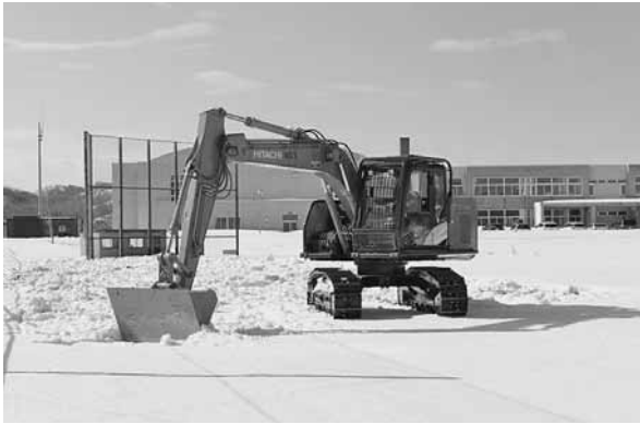
雪割りを行う重機
