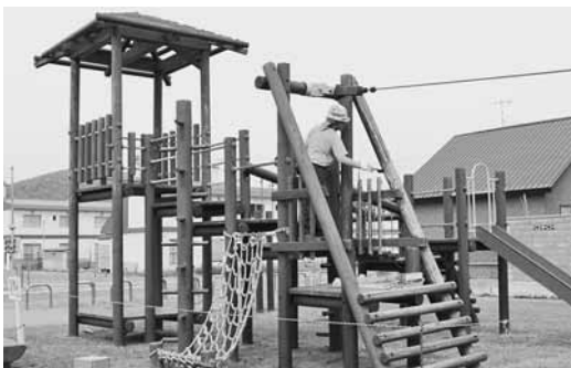
株式会社伊藤塗工部（札幌市）様 （伊藤龍平代表取締役） 小平中央公園遊具の塗装作業を実施
