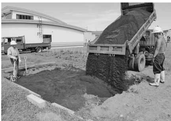
造成作業中の砂場
