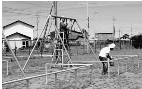
有限会社坪田塗装 様 (坪田幸治代表取締役) 小平小学校遊具塗装作業を実施
