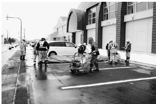
堀松建設工業株式会社 様 (堀松一郎代表取締役社長) 小平小学校駐車場区画線復旧作業を実施
