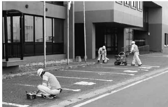
山田塗装株式会社札幌支店 様 (渡辺巖支店長) 小平町役場来客者用駐車場区画線復旧作業を実施
