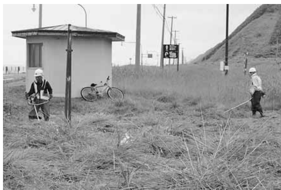
高橋土木工業 株式会社 様 大楸地区バス停裏周辺の草刈り作業を実施
