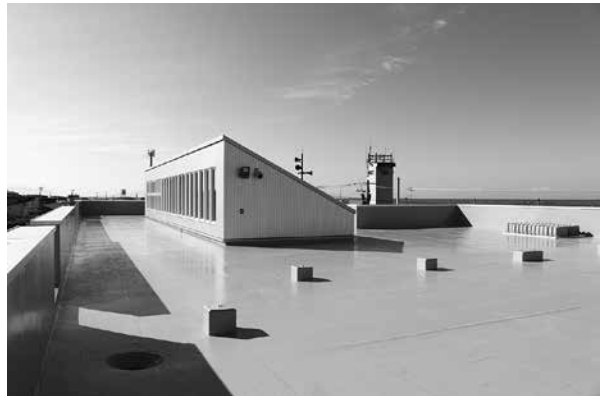
▶屋上の津波避難場所
