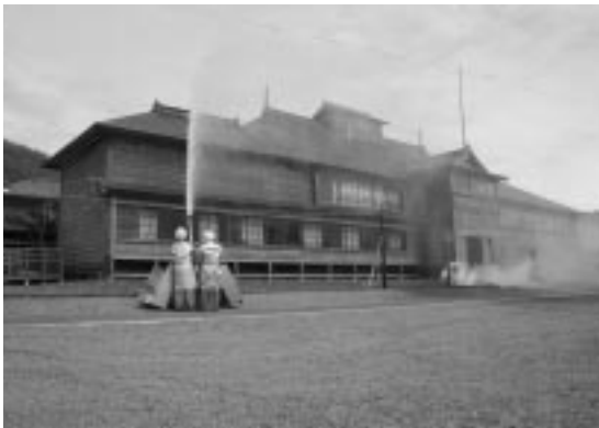
3基の放水銃を使って行われた防火訓練
