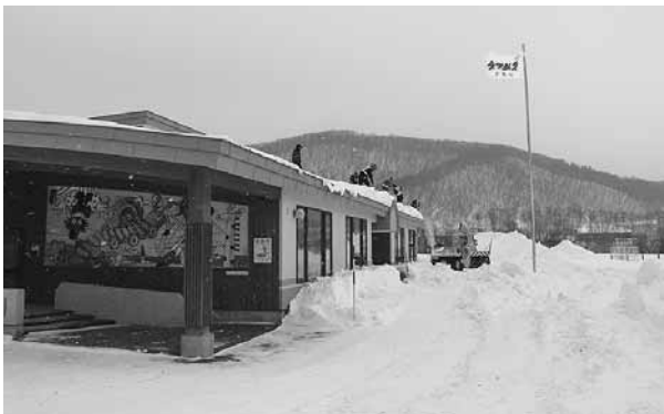
ヤマモト巧建株式会社 山本 博行 代表取締役 様 小平町立小平幼稚園の屋根雪下ろし・周辺排雪・ 雪山造りを実施 (2/11)
