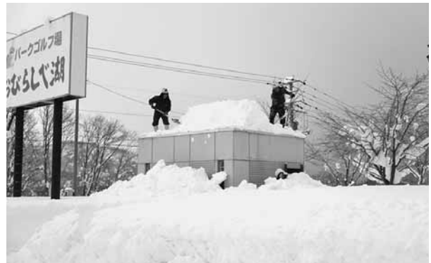
向井・菊地経常建設共同企業体 株式会社 向井建設 向井 勝広 代表取締役 様 多目的活性化広場内の四阿およびトイレの屋根 雪下ろし作業を実施 (2/3)
