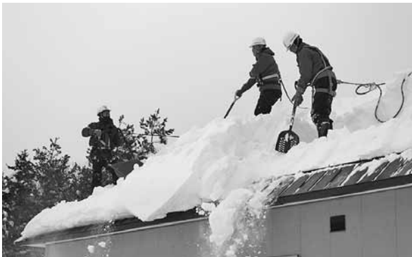
興北建設株式会社 原田 欣典 代表取締役社長 様 達布集落センター屋根の雪下ろし作業を実施 (2/1)
