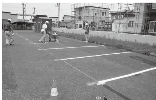
北進開発株式会社（中村弘一代表取締役）様 7/10 愛生園駐車場区画線塗装を実施
