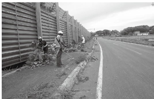
萌州建設株式会社（畑中修平代表取締役）様 6/23 沖内左岸線道路清掃作業を実施
