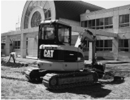
グラウンド整地作業に汗を流す増毛土建従業員
