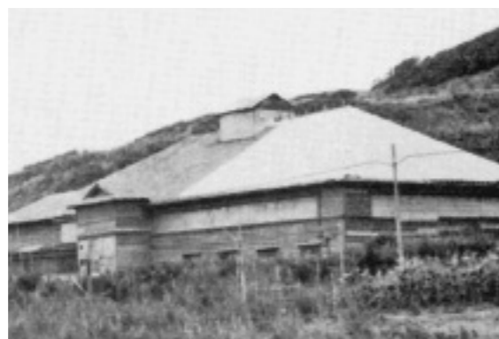
解体修復前の旧花田家番屋 (640号・昭和57年6月号掲載)
